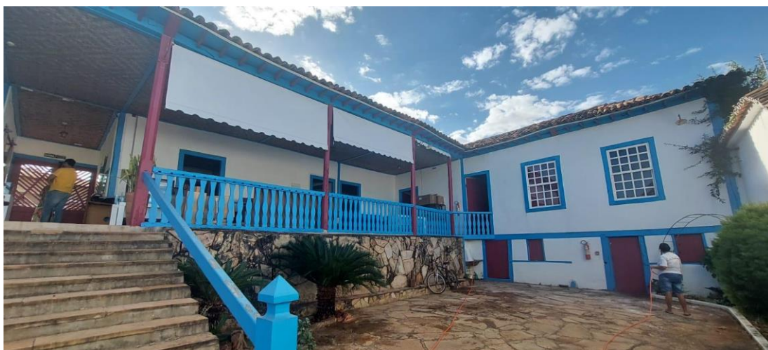
Vista interna do Museu Histórico Municipal de Paracatu – toldos instalados Autoria: Maria Letícia Ticle Data: 24/06/2024
